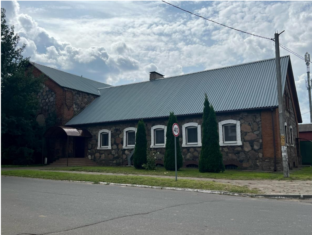
Комплекс бывлой сядзібы "алесіна": склад
