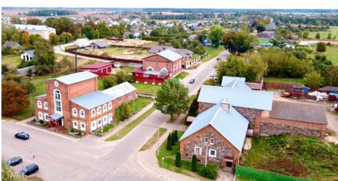
Комплекс бывлой сядзібы "Алесіна": дом, гаспадарчая прыбудова, бровар (частка 1), бровар (частка 2), склад, гараж.
